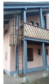
Fluchtleiter vom Balkon, der von den Schlafräumen erreichbar ist
